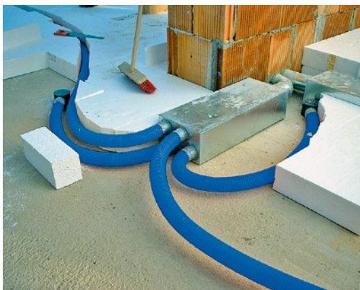
Detail zakázkového rozdělovače EDF-M-BOX a jednotlivých boxů, pro odvodní talířové ventily na půdě budovy, před dokončením a zakrytím izolace
