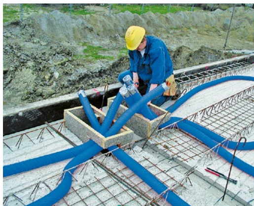
Detail pokládky hadice ED Flex® 75/63 do armování základové desky
