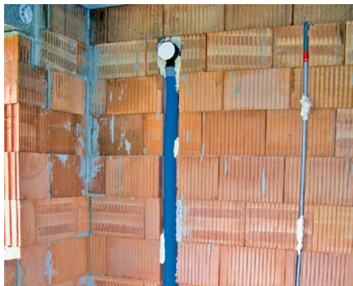
Detail přechodu hadice ED Flex® 75/63 do jímky pro talířový ventil EDF-SJ-100/75
