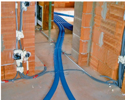
Detail vedení hadice ED Flex® 75/63 od rozdělovače k distribučním elementům
